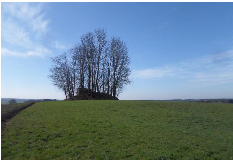
Abb. 12: Feldgehölz auf dem Wasserhochbehälter
