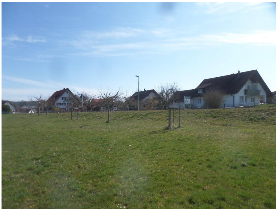
Abb. 7: Böschung der K 7560
